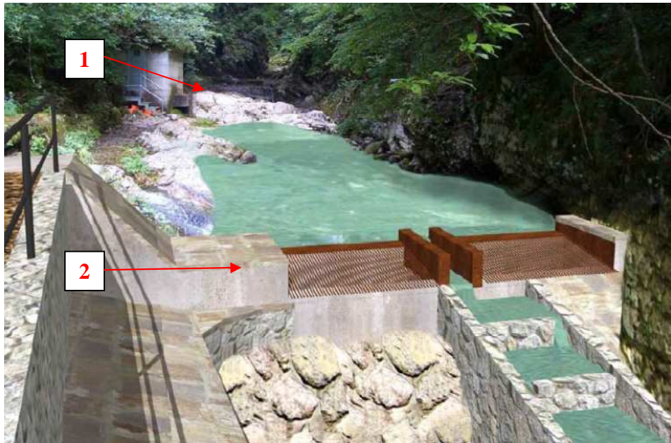
Figura 1 - Fotorealismo dell'opera di presa dell'acquedotto comunale (1) e dell'inserimento dell'opera di presa idroelettrica (2) con il sovrastante invaso
