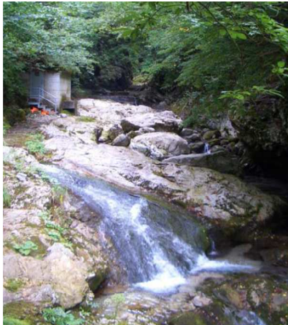
Figura 44 - Torrente Leale: opera di presa dell'acquedotto comunale
