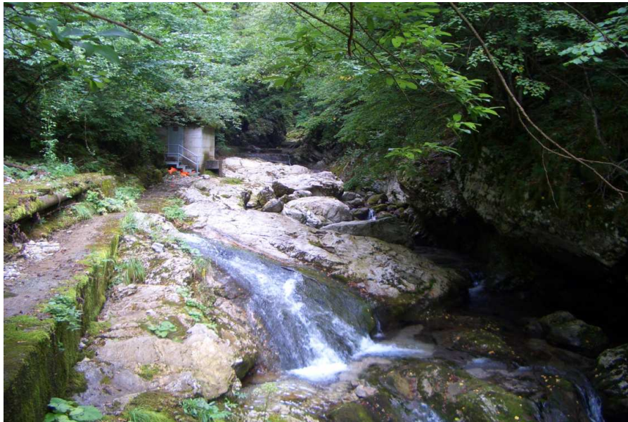
Figura 11 - Immagine dell'opera di presa dell'acquedotto comunale
